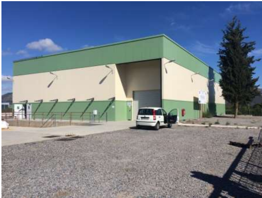
Εικ.1: Εγκατάσταση διαχείρισης ΕΑΥΜ στην ΒΙ.ΠΕ. Τρίπολης
